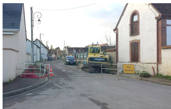
Enfouissement des réseaux sur toute la longueur de la Rue des Graviers et installation d'un nouvel éclairage public.
