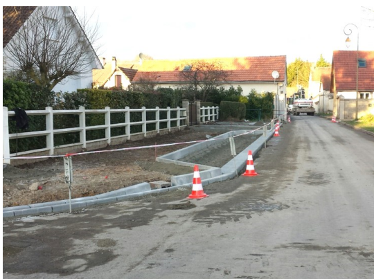
Création de places de stationnement Rue Saint Médard haut et bas. Et plusieurs marquages au sol, couloirs piétons et passages piétons.
